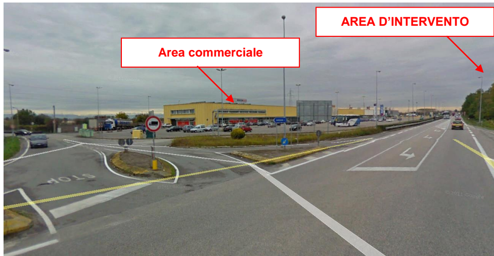
Figura 46: Vista da Sud-Ovest, S.S. Romea in direzione Nord, distanza dal Sito circa 150 m, distanza dai fabbricati commerciali circa 100 m (fonte: Google Earth Pro, Street View; immagine acquisita a settembre 2011).
