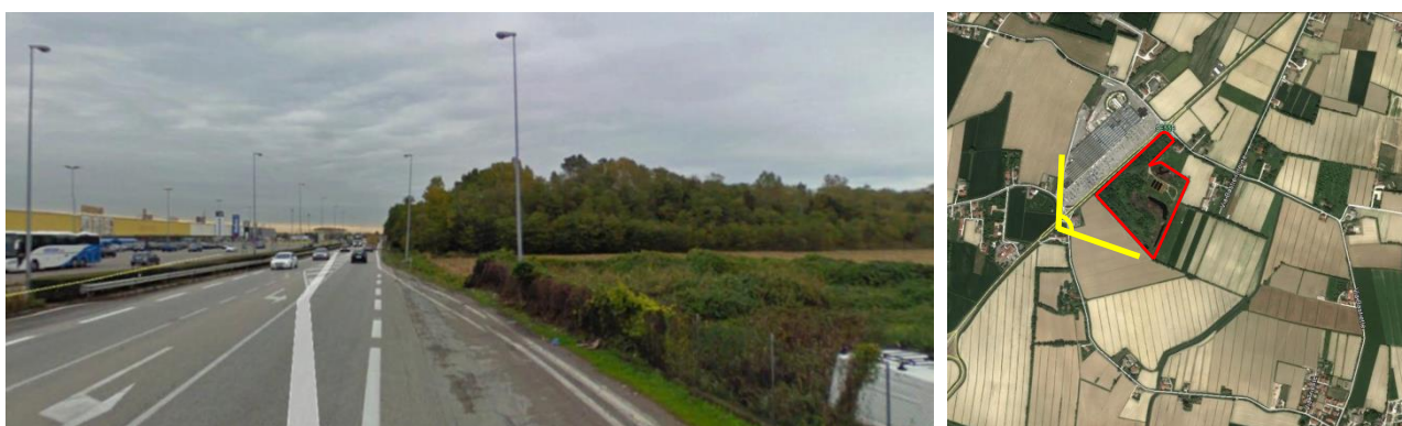
Figura 24: Vista da Sud-Ovest, S.S. Romea in direzione Nord, distanza dal Sito circa 150 m (fonte: Google Earth Pro, Street View; immagine acquisita a settembre 2011).
