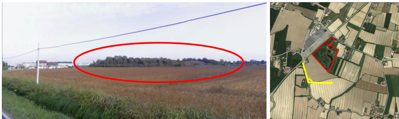
Figura 28: Vista da Sud-Ovest, Via Bastie, distanza dal Sito circa 300 m (fonte: Google Earth Pro, Street View; immagine acquisita ad ottobre 2008).
