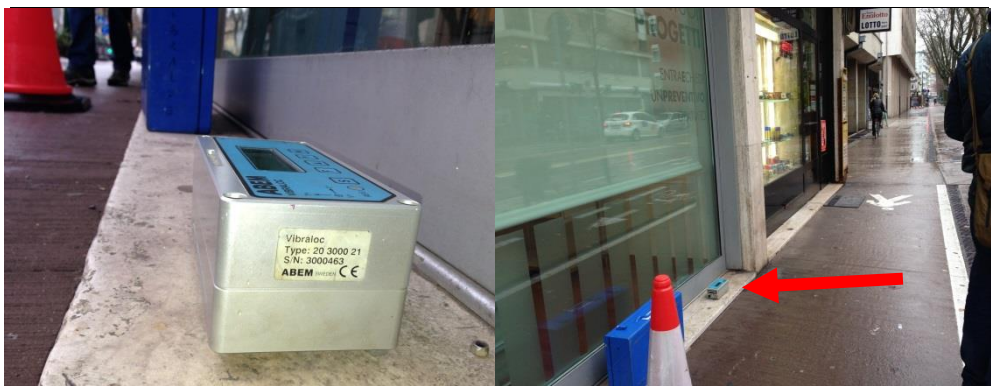
Terna triassiale in posizione adiacente alle fondazioni dell'edificio - Vibraloc n°463
