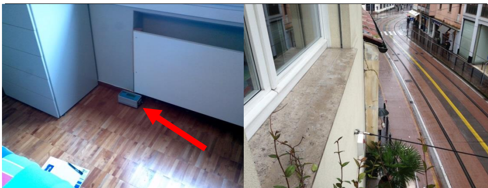
Terna triassiale a 2° piano in corrispondenza di tirante su muro esterno - Vibracloc n° 496
