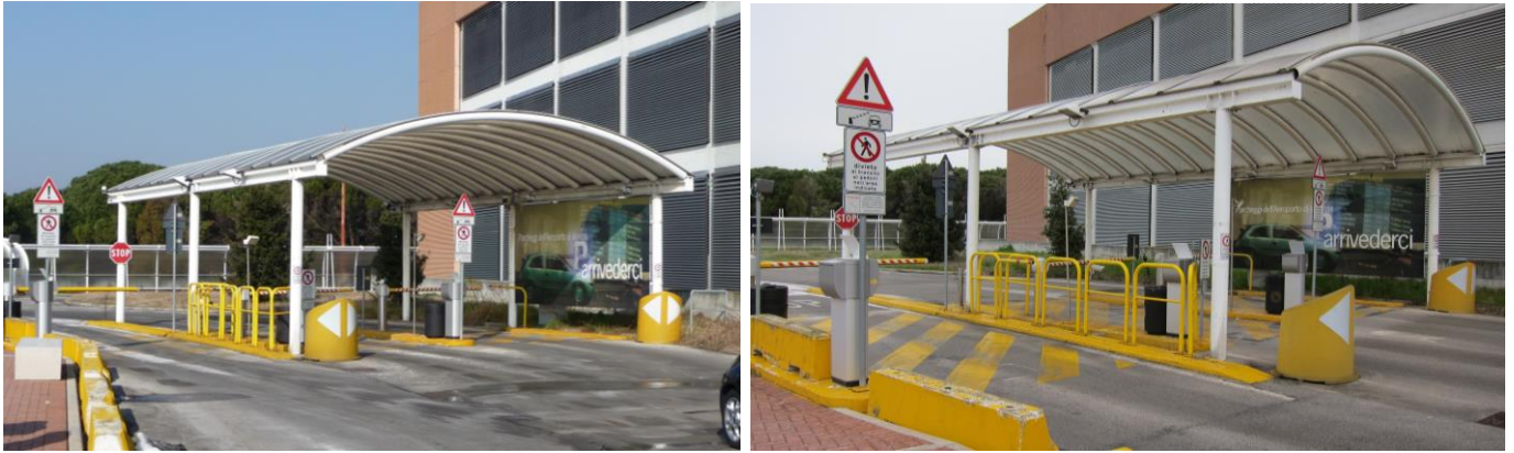
Figura 3.4: Pensilina e varchi in uscita dal parcheggio Marco Polo
