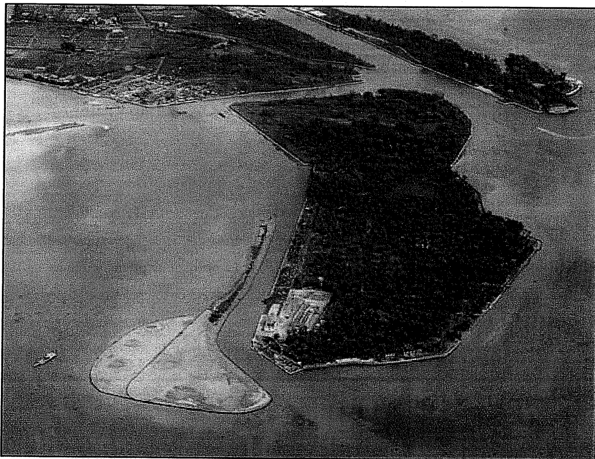
Fig. 5/1 – Veduta aerea dell'Isola La Certosa in direzione nord-est
