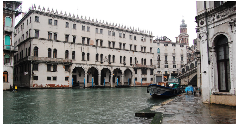
Vista odierna dell'edificio
