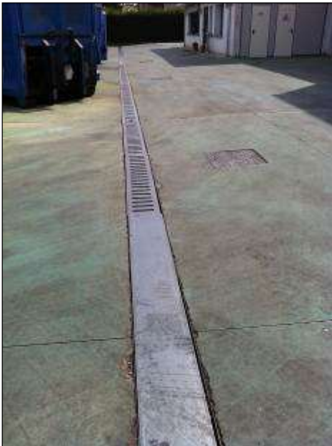
Fig. 26: Caditoie grigliate presenti sul piazzale
