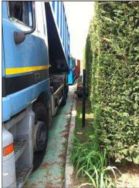
Fig. 28: Cordolo perimetrale di protezione delle aree verdi adiacenti al piazzale
