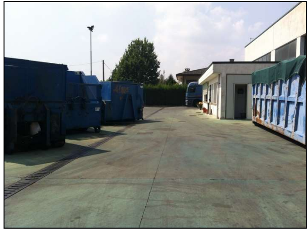
Fig. 2 - area deposito cassoni vuoti
