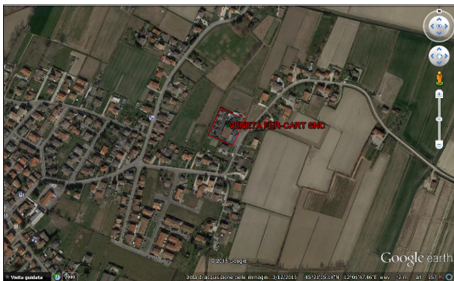
Fig. 24: Foto aerea localizzazione impianto in contesto paesaggistico
