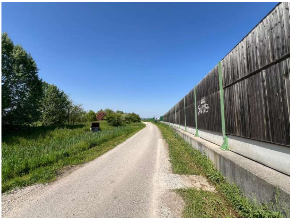
Fotografia 6 – Viabilità di servizio lungo il “Passante” verso l’impianto
