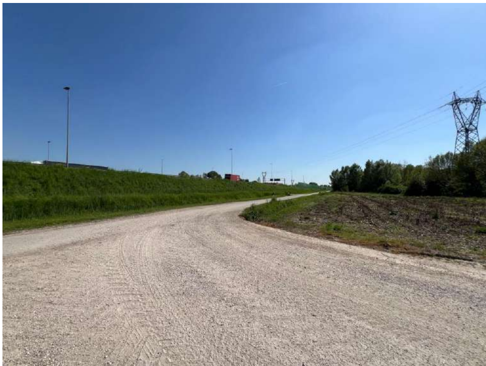
Fotografia 10 – Viabilità di servizio con rilevato del "Passante"
