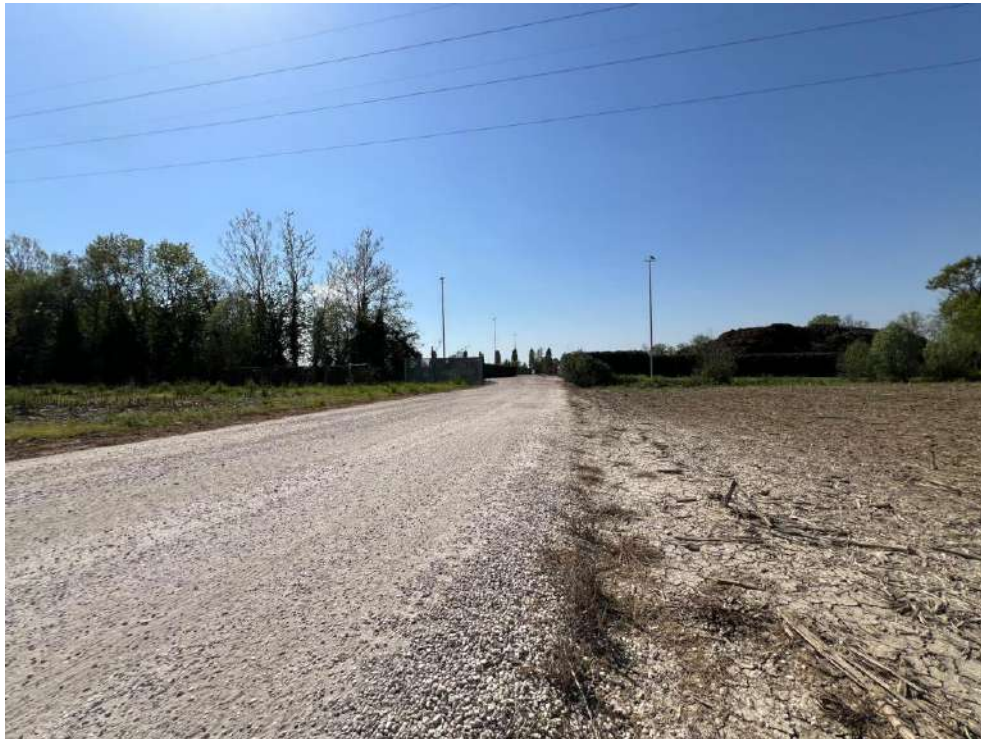
Fotografia 9 – Viabilità verso l'accesso principale all'impianto
