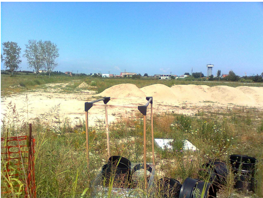
Immagine n° 52 – Cantiere 2011: proseguono i lavori per la realizzazione delle opere di urbanizzazione (fonte: Rampado, 2011)
