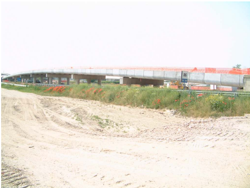
Immagine n° 96 – Foto n°4 – Sopra, cantiere per la realizzazione dello svincolo prospiciente all'area e Sotto lo svincolo terminato (Pizzato Rampado 2006-2009)
