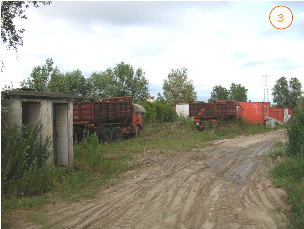
Immagine n° 95 – Foto n° 3 - Degrado esistente prima dell'intervento costituito dall'abbandono di mezzi e da manufatti provvisori non utilizzati (fonte: Pizzato Rampado, 2006)
