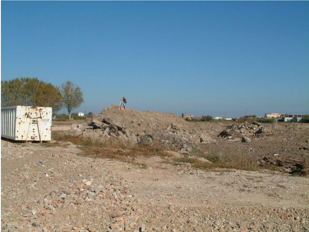
Immagine n° 51 – Cantiere 2007: lavori di sbancamento per la realizzazione delle opere di urbanizzazione (fonte: STAP, 2007)
