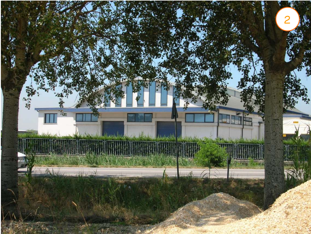
Immagine n° 94 – Foto n° 2 - Capannone produttivo prospiciente l'ambito di intervento lungo la Romea (fonte: Rampado)
