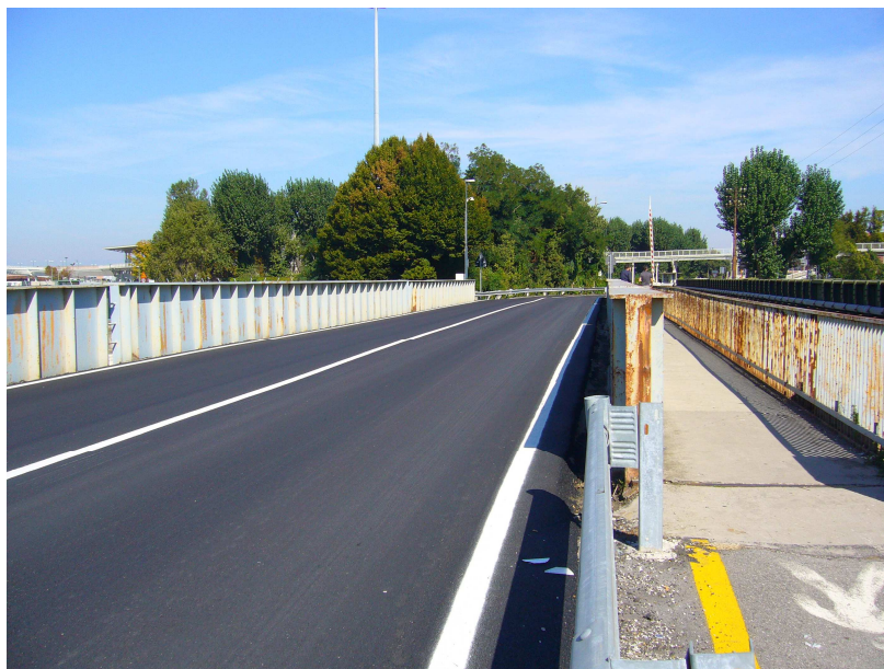
Figura 3 – Ponte stradale sul canale della Scomezera.
