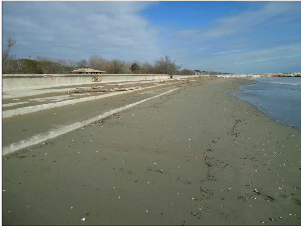
Arenile prospiciente l'area di intervento con barriera di protezione in cls
