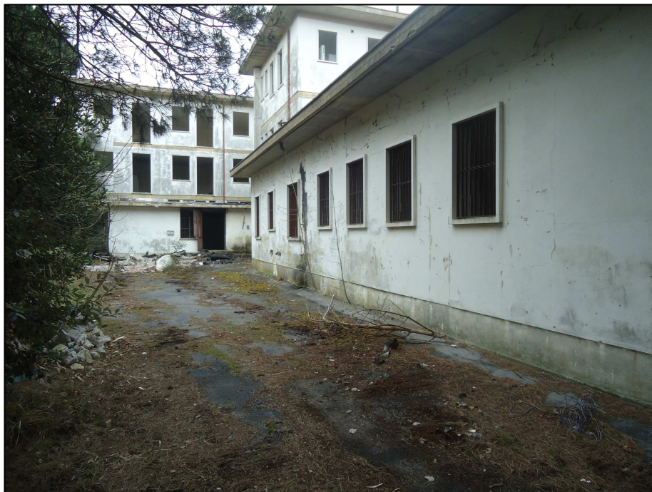
Edificio principale, lato est – zona di posizionamento dell'impianto
