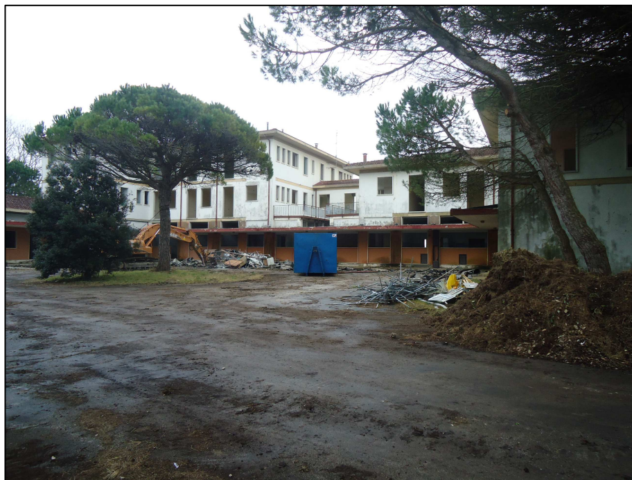
Edificio principale, lato nord con piazzale asfaltato
