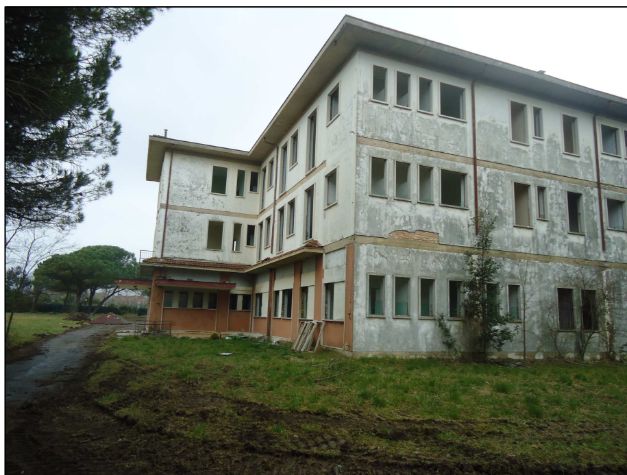
Edificio principale visto da est
