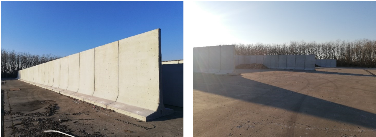
Figura 7: Foto dei silos esterni installati.
