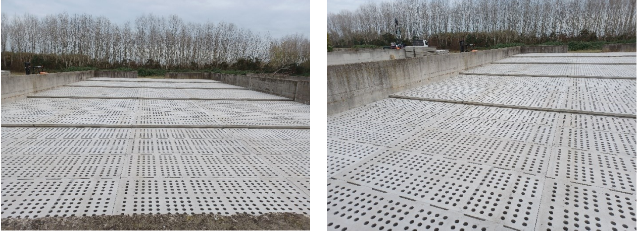
Figura 5: Foto della platea aerata installata all'interno dei due biofiltri.
