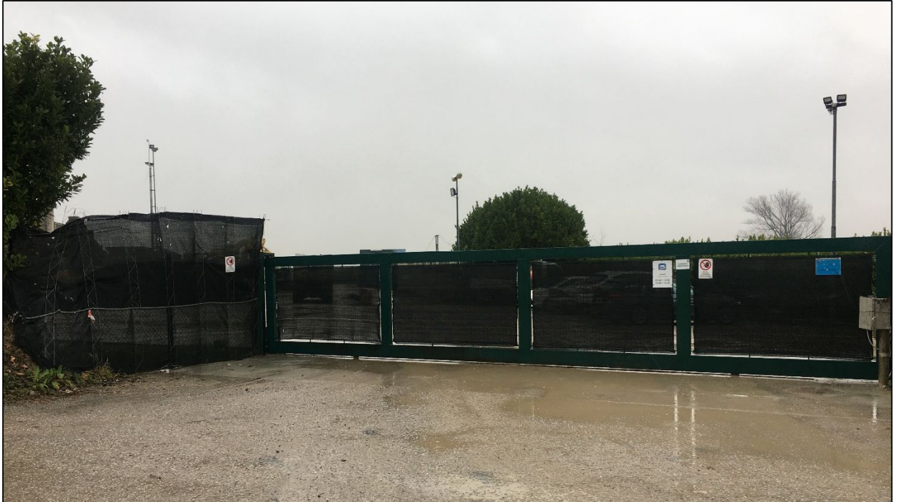
Figura 13.6. Visuale dell'impianto n. 5 in corrispondenza del cancello di ingresso
