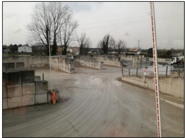
Fig. 6: Vista piazzale e deposito materie prime inerti
