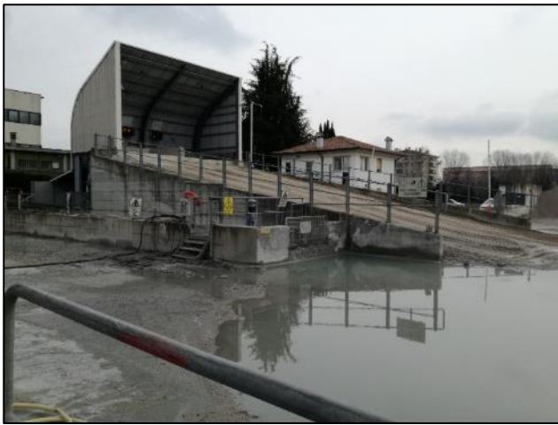
Fig. 7: Rampa carico inerti su tramogge
