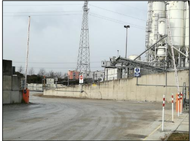
Fig. 4: Vista impianto da ingresso mezzi
