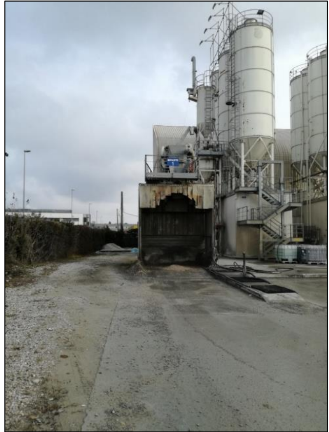
Fig. 12: Bocca di carico mezzo
