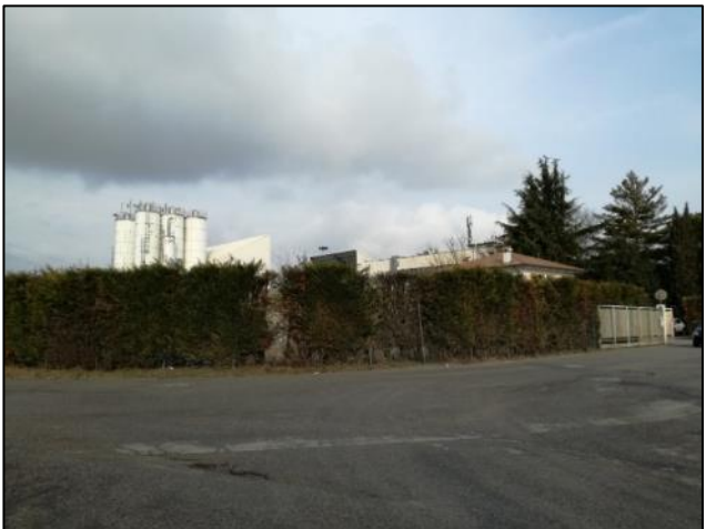
Fig. 14: Vista impianto da esterno
