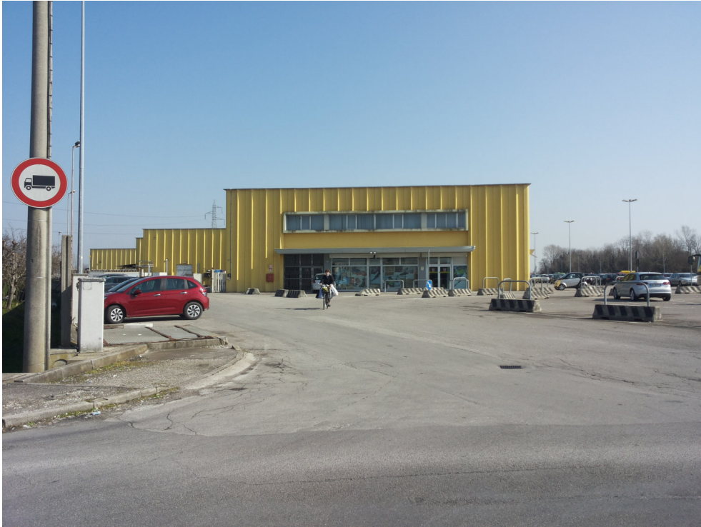
01_ vista del lato ovest da via Bastie
