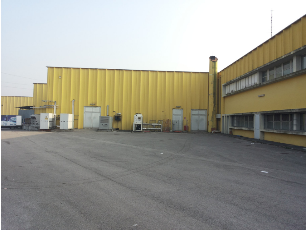
09_ particolare della prima area carico/scarico a nord
