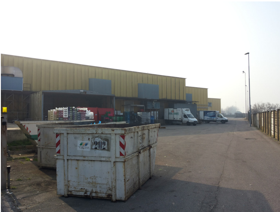
10_ vista dell'area carico/scarico da nord-est
