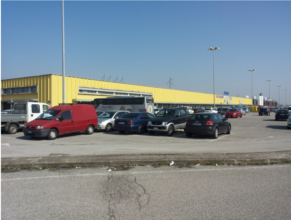
03_ vista del lato sud dell'intero edificio
