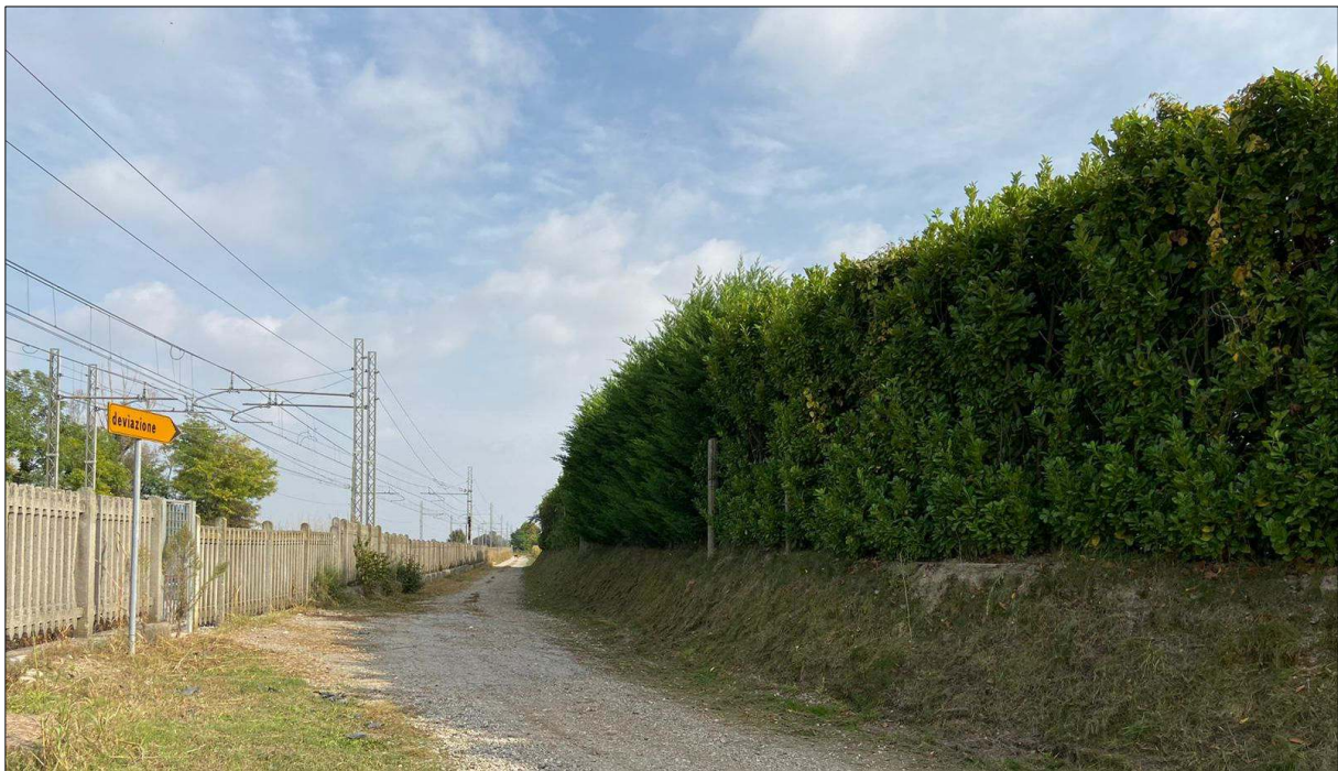
Figura 3.3. Vista del confine Nord a ridosso della linea ferroviaria
