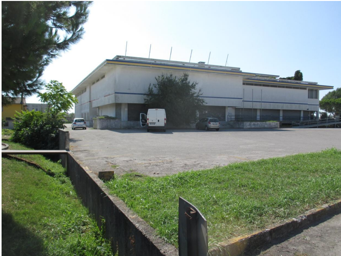
Figura 5: Foto dell'edificio da via Panama
