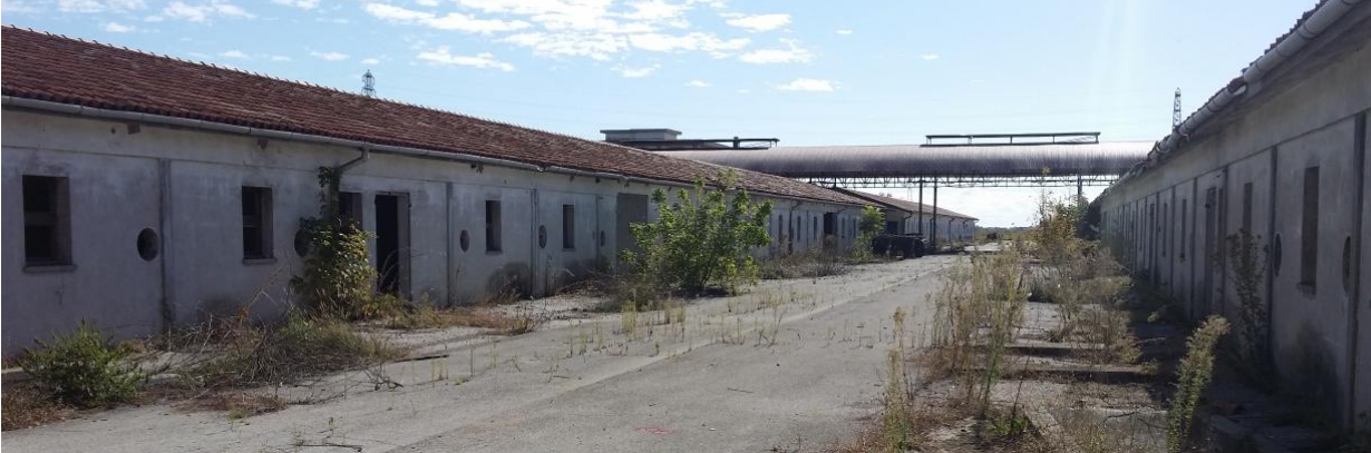
Edifici D1 (come da stato di fatto iniatoci) Capannoni destinati ad allevamento avicolo
