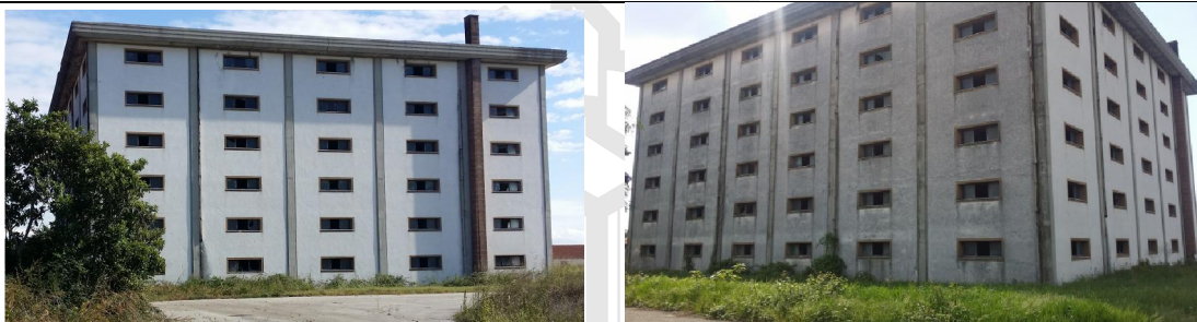
Edificio A2 (come da stato di fatto inviatici) – Palazzina multipiano
