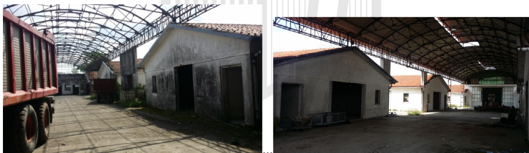
Foto stato di fatto
