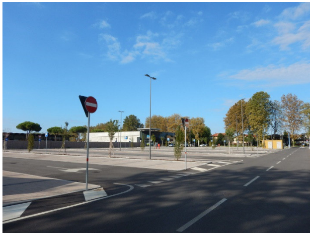
Figura 8 Foto n. 3 – Vista da Via Mameli in direzione sud-ovest.
