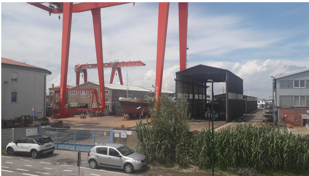
Figura 8 – Vista dai Murazzi – stato di fatto
