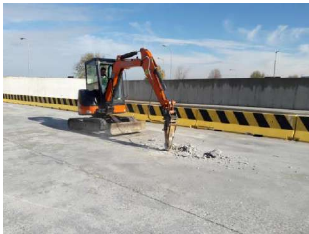
Figura 8.41 - Utilizzo di martello demolitore per prelievi in presenza di pavimentazione in c.a. – area deposito sabbia
