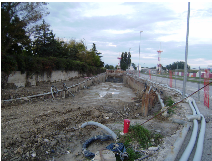
Figura 16. Immagine fotografica dei lavori di realizzazione del nuovo tratto tombinato dello scolo Pagliaghetta.
