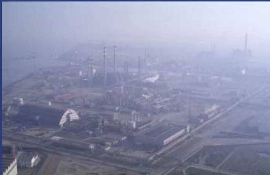
Sia per i vecchi reparti cloro-soda del '50, sia per quelli nuovi del '70 la scelta tecnologica venne orientata verso le celle ad amalgama anche quando in altri Paesi queste venivano ad essere sostituite con la tecnologia a membrana, indubbiamente migliore da un punto di vista ambientale ma anche economico e gestionale.
