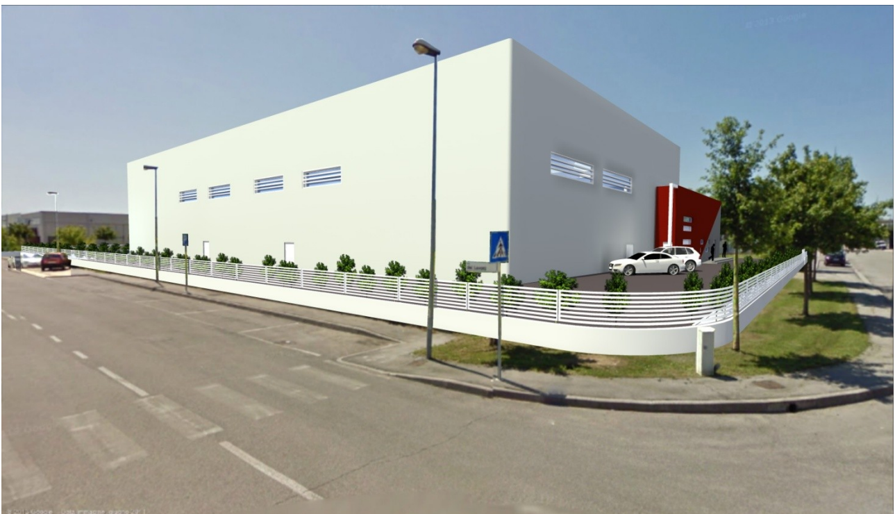
Figura 11 – Vista Nord (angolo Via dell'Industria con Via del Lavoro)
