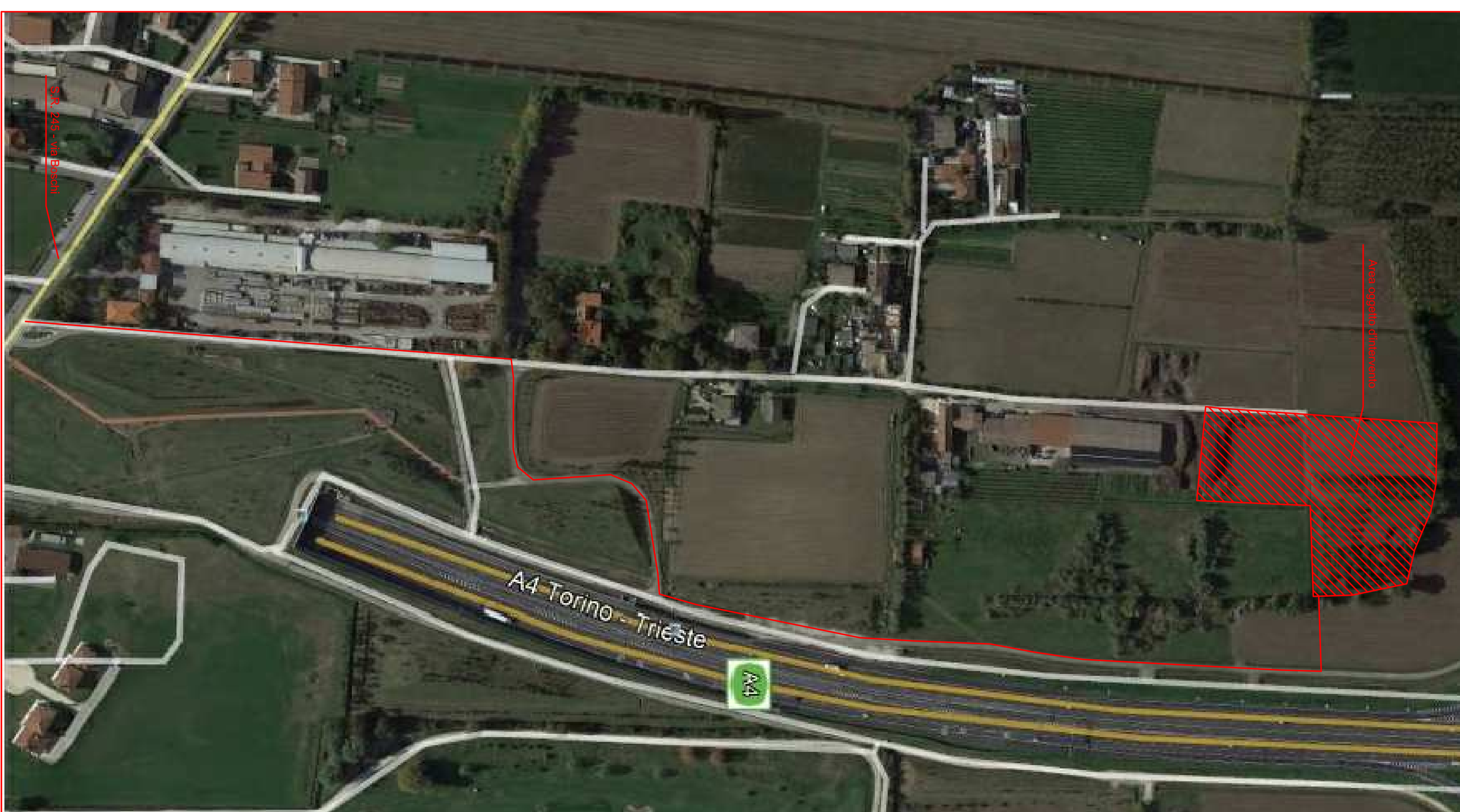
VISTA AEREA CON VIABILITÀ PER RAGGIUNGIMENTO SITO Fotografia di scala non utilizzabile
