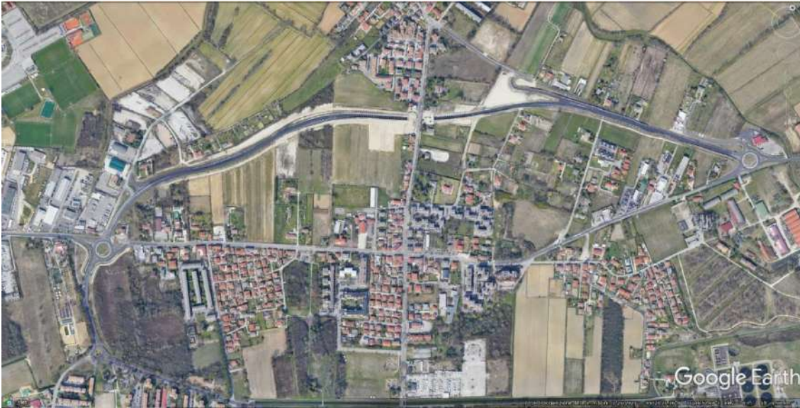
Figura 3-15: Vista della S.S. 14 nel tratto presso l'abitato di Campalto e della Variante di Campalto che condente di by-passare il centro abitato
