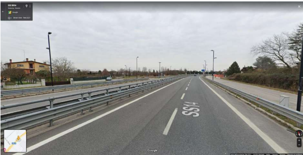
Figura 3-12: Vista della S.S. 14 nel tratto di fronte all'Aeroporto Marco Polo di Venezia
