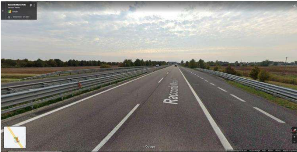
Figura 5-112: Vista della bretella di raccordo all'aeroporto Marco Polo (MP) nel tratto in affiancamento all'area di intervento
