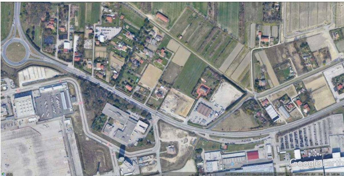
Figura 5-114: Vista della S.S. 14 ad est dell'Aeroporto Marco Polo presso via A. Ca' Da Mosto
