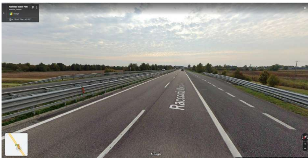
Figura 3-11: Vista della Bretella di raccordo all'Aeroporto Marco Polo (MP) nel tratto in affiancamento all'area di intervento
