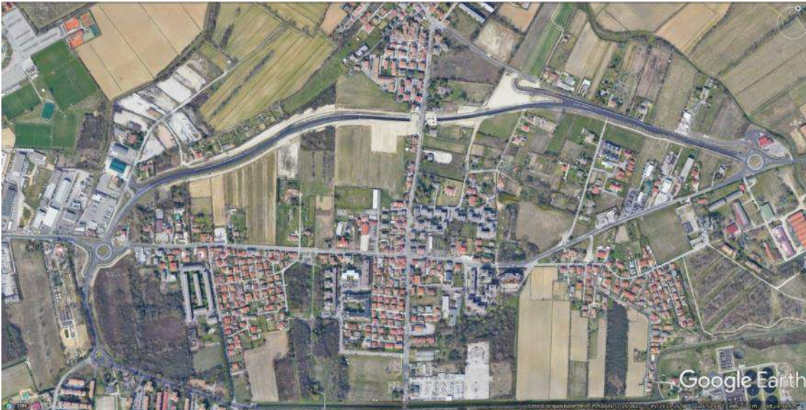
Figura 5-117: Vista della S.S. 14 nel tratto presso l'abitato di Campalto e della Variante di Campalto che condente di by-passare il centro abitato
