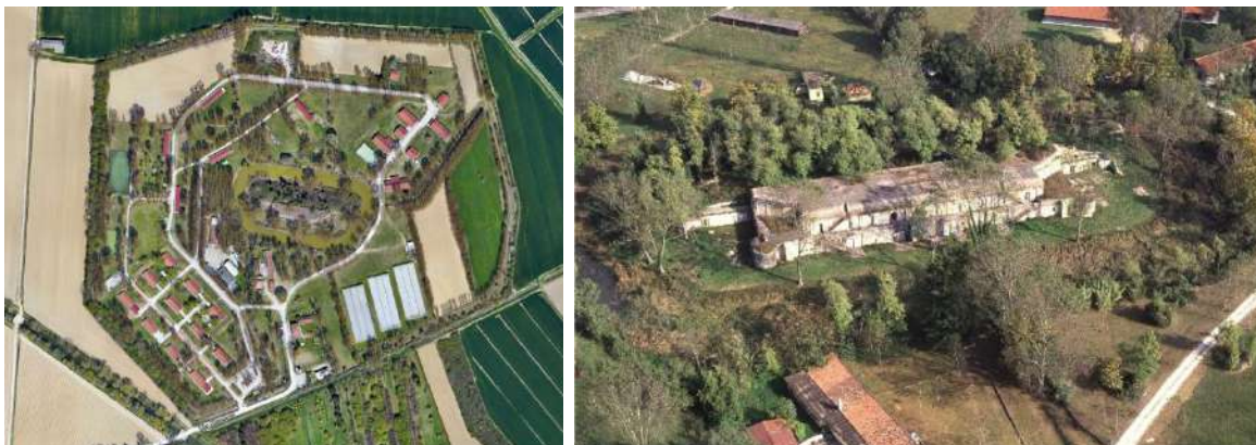
Figura 5-135: Veduta aerea e dall'alto di Forte Rossarol
