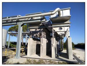
• LATO OVEST – sono stati installati i portoni per la chiusura della sala compressori soffianti dell'impianto di depurazione fatti in lamiera zincata verniciata rigata interna ed esterna con coibentazione da 50 mm di poliuretano espanso.
