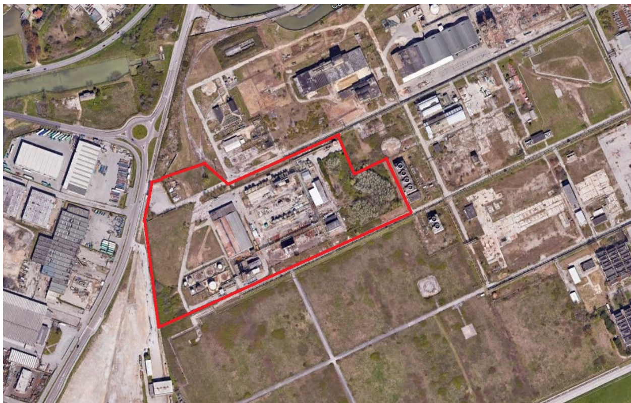
Fig. 3.1 - Vista dello stabilimento (tratta da Google Earth) con indicazione dei confini di stabilimento (in rosso).
