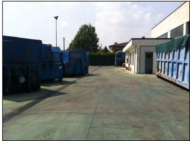
Fig. 2 - area deposito cassoni vuoti
