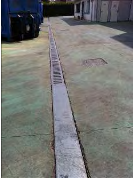
Fig. 15: Caditoie grigliate presenti sul piazzale
