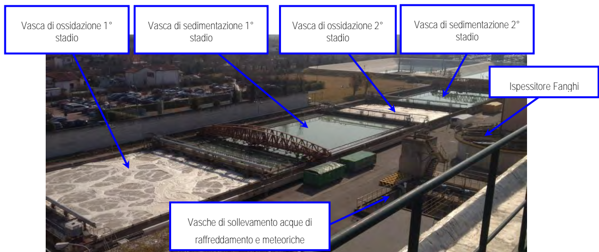
Figura 14- Principali sezioni di trattamento dell'impianto
