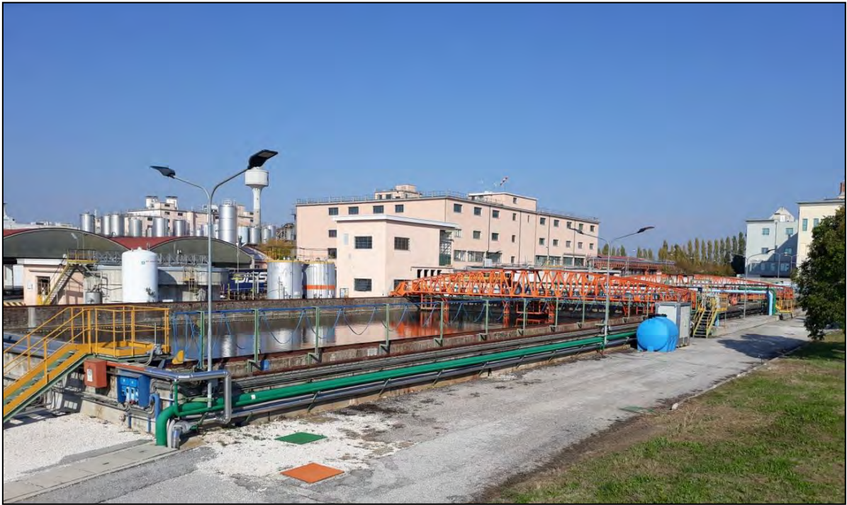
Figura 16– Impianto di depurazione
