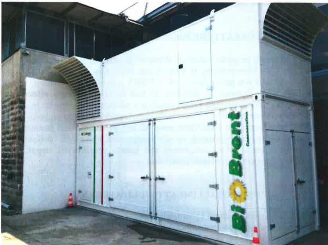
L'installazione dell'impianto prevede la realizzazione di una platea cementata sopra una platea esistente ; le linee elettriche, acqua calda e vapore saranno tutte di tipo aereo fuori terra per evitare la realizzazione di scavi e successivi reinterri.
