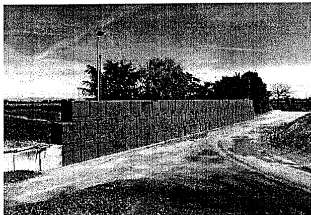
Foto 1 – Lato Nord con barriera fonoassorbente esistente e angolo Nord-Est dove verrà posizionata la nuova barriera fonoassorbente
