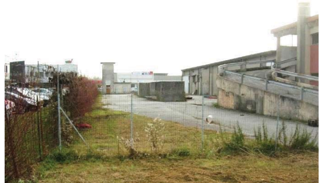
Foto 2: veduta da via Calvecchia, angolo nord-est.
