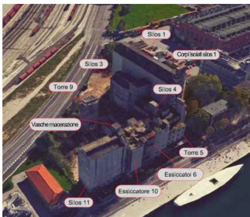
Fig. 4 - Identificazione edifici oggetto di demolizione
