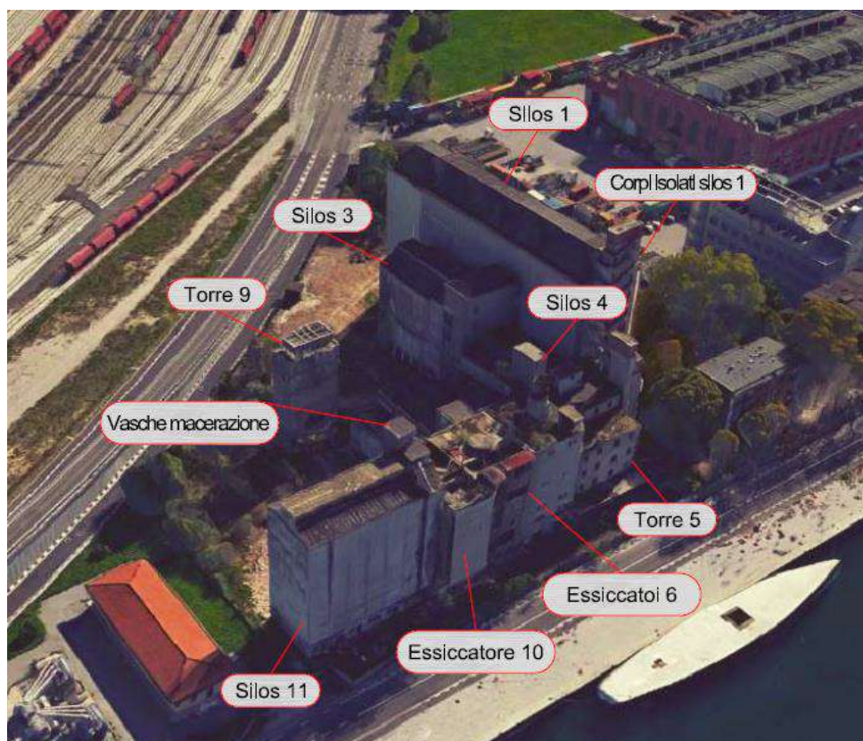
Fig. 5 - Identificazione edifici oggetto di demolizione
