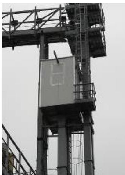
Tamponamento con pannelli monopanel di spessore 40 mm
