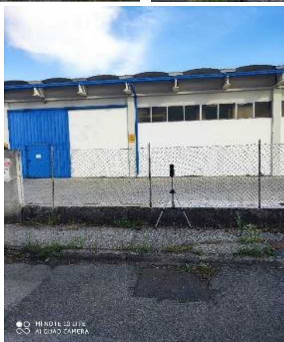
Lato/versante Est – direzione zona industriale
