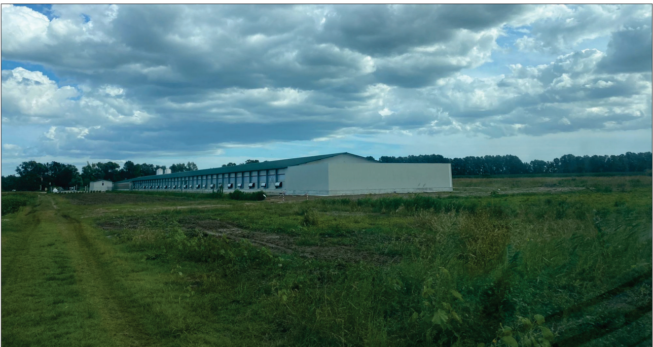
Figura 11: vista del lato ovest dell'area d'intervento
