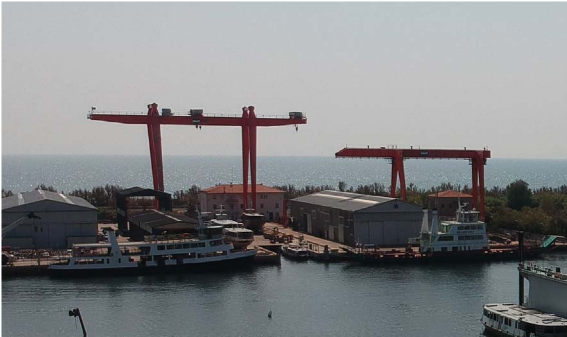
TESTE MOBILI – vista lato ovest – Stato di Fatto
