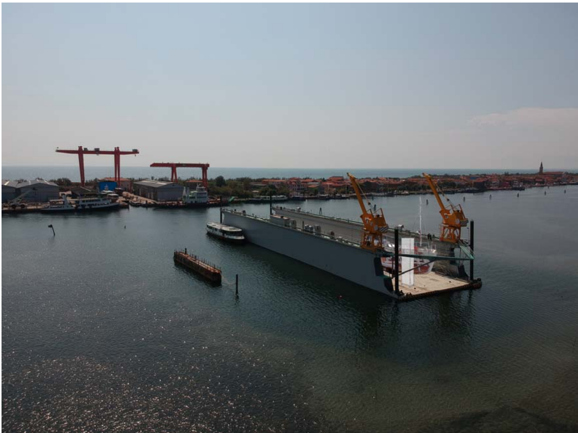
Bacino di carenaggio – con imbarcazione e ponteggio mobile
