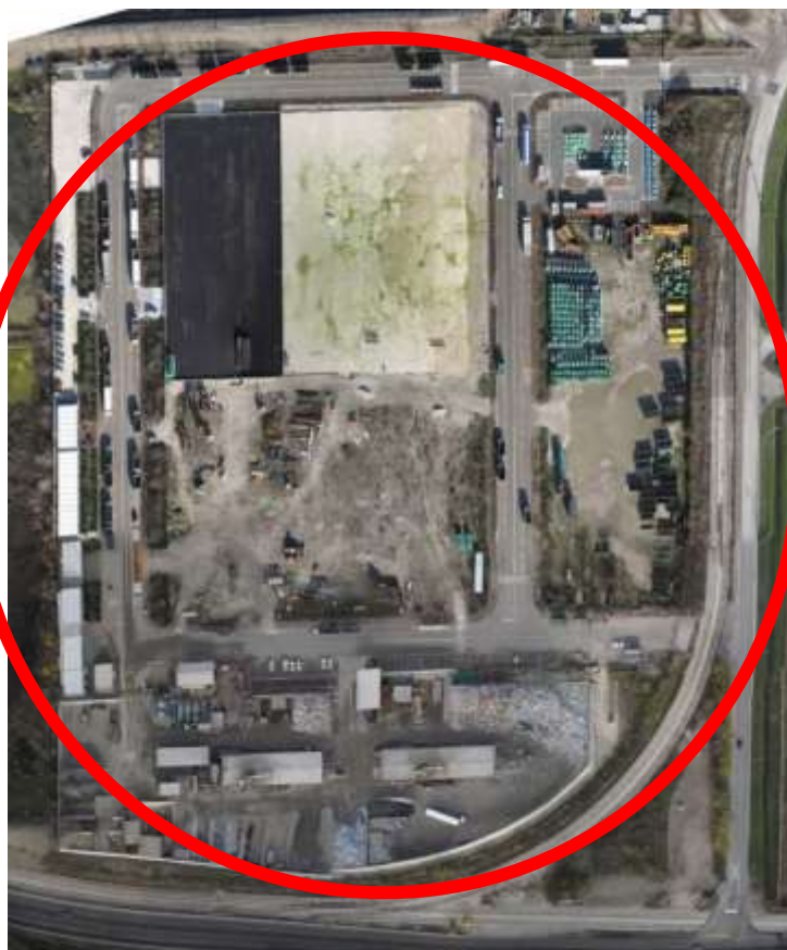
Figura 4.1.1 – Fotopiano con indicata l'area d'intervento
