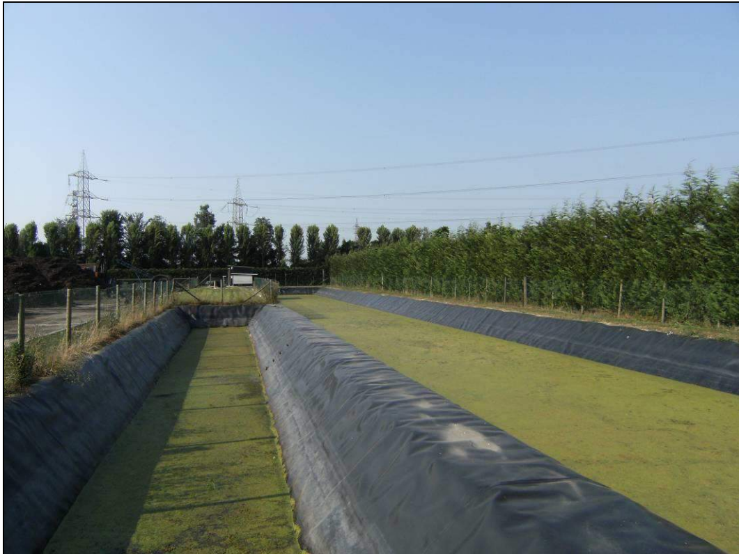
Foto 11 – Vasche di raccolta acque prima pioggia e laminazione.
