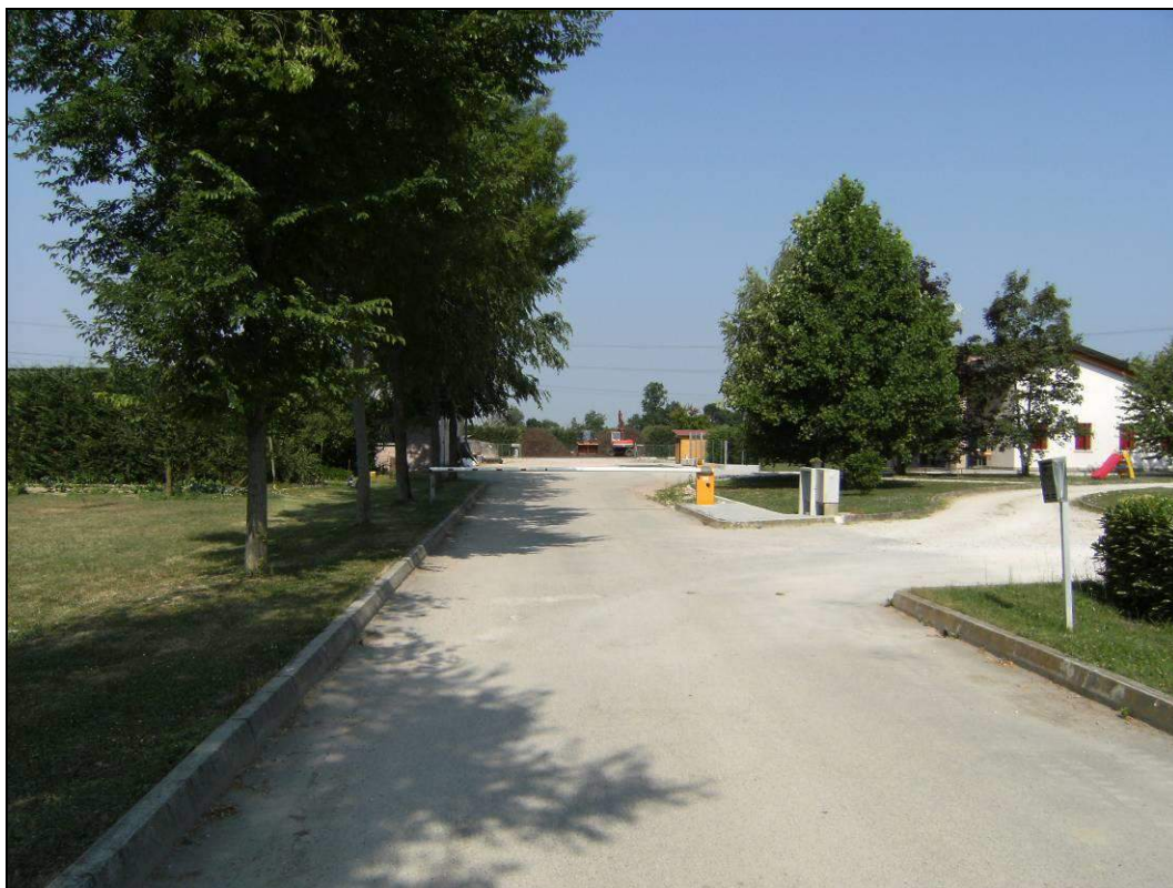
Foto 3 – Vista dell'ingresso all'impianto – Sbarra controllata.
