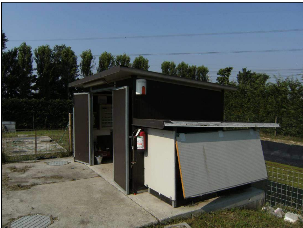
Foto 12 – Locali di servizio dell'impianto di depurazione.
