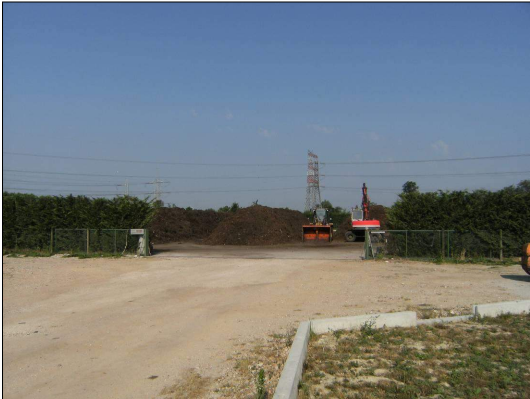
Foto 5 – Accesso principale all'impianto.
