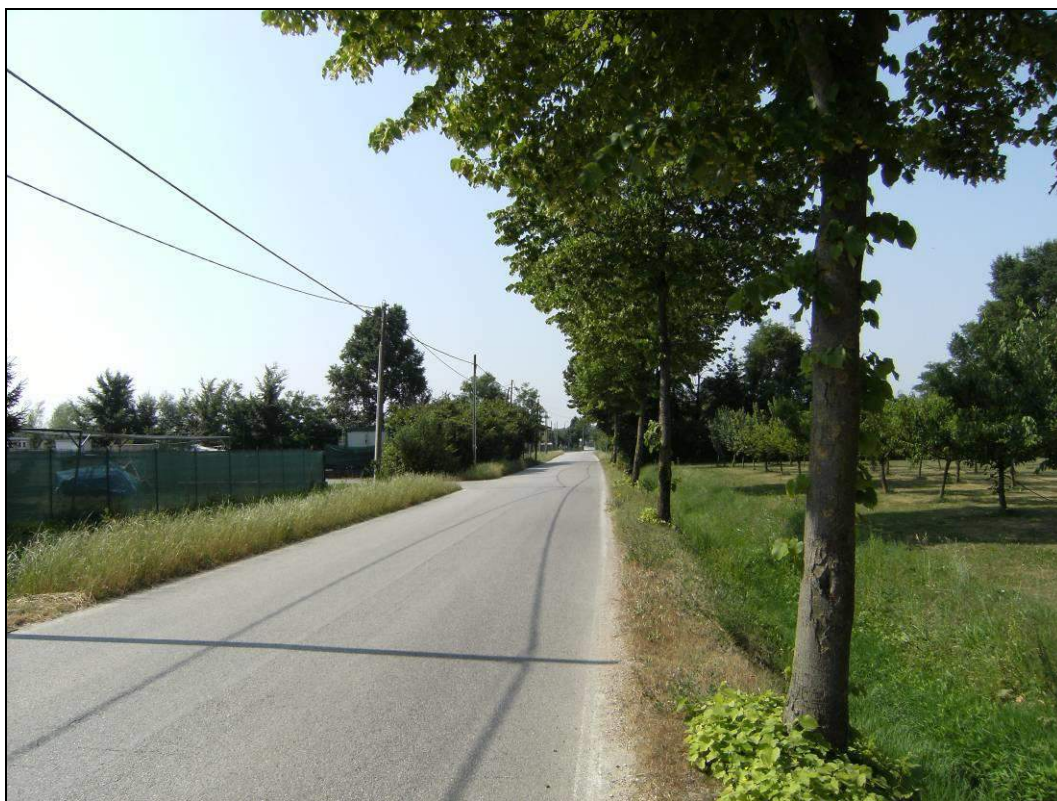
Foto 2 – Vista dall'ingresso all'impianto da Via Canaletto – Direzione Sud.
