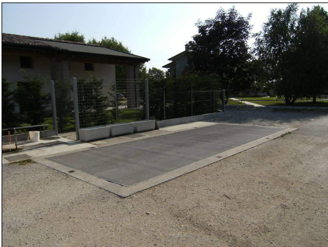
Foto 4 – Vista della pesa all'ingresso dell'impianto.
