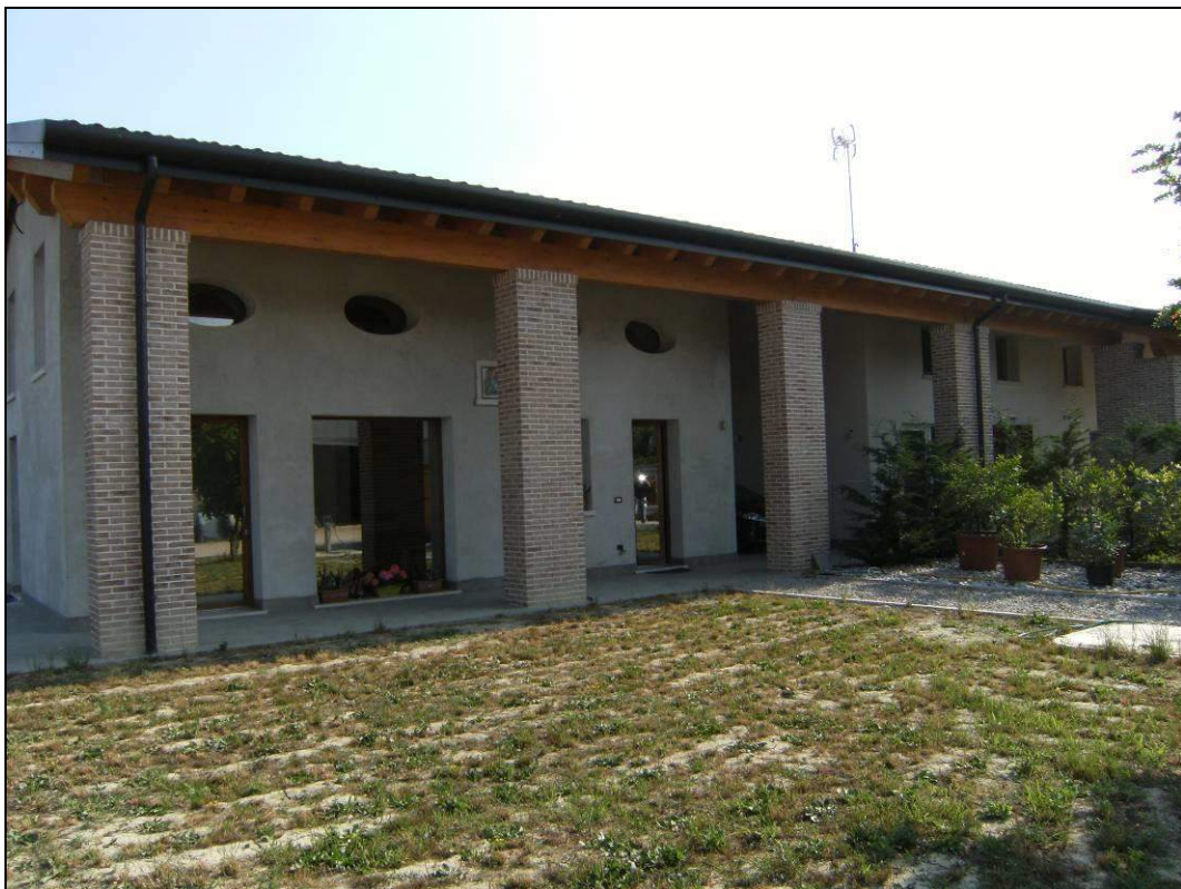
Foto 6 – Fabbricato uffici e servizi.
