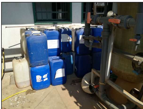
Foto 1: Deposito reagenti per impianto chimico-fisico trattamento acque
