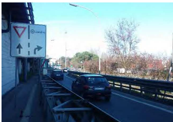
Figura 25 – Rampa sud Tangenziale
