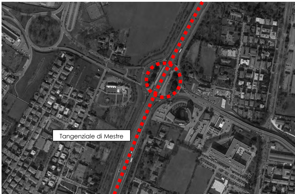
Figura 16 – Vista aerea Tangenziale di Mestre
