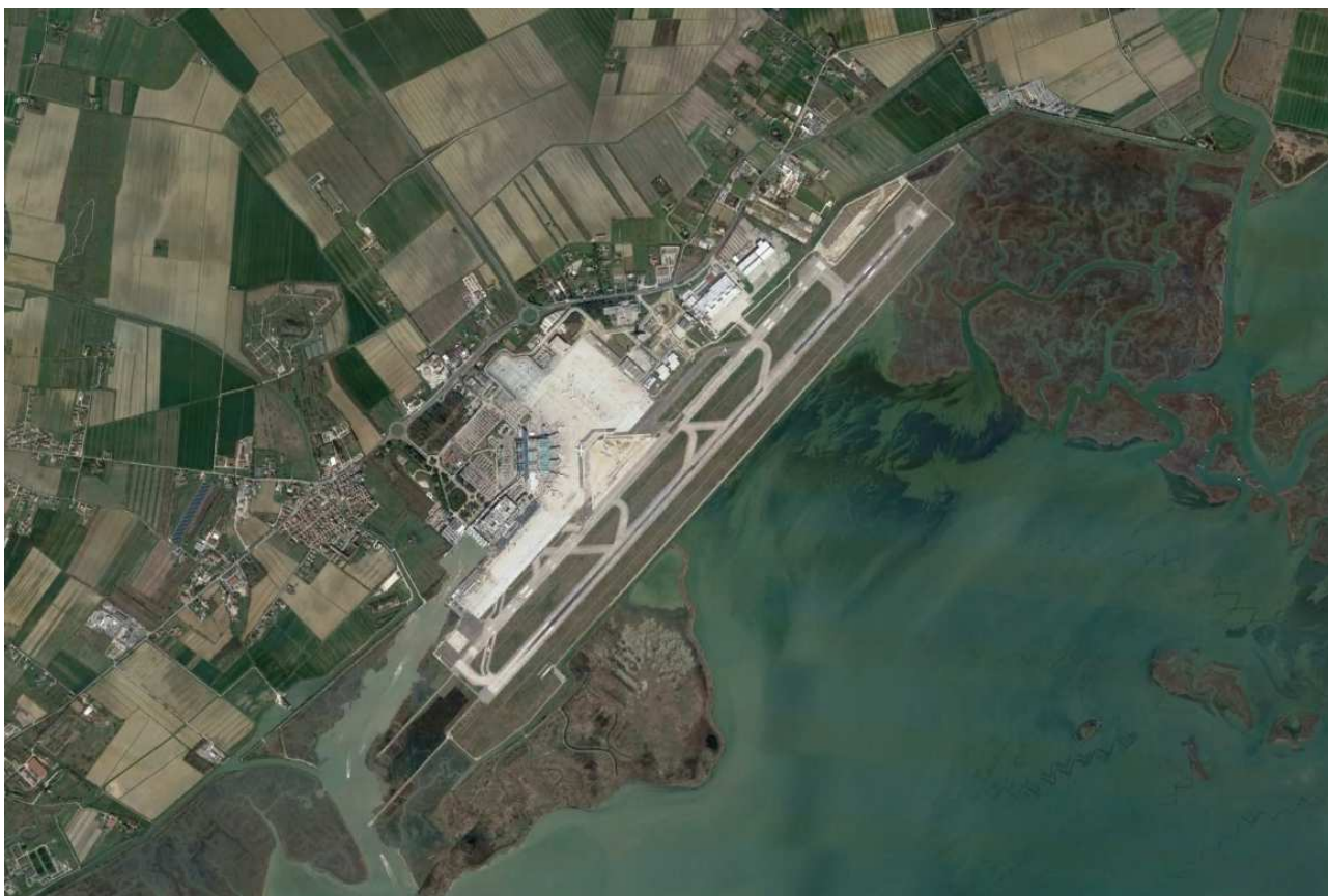
Figura 3. Ripresa aerea della struttura aeroportuale (Fonte: Google Earth)
