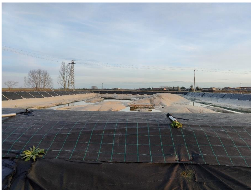
Foto 16. Serbatoio elastomerico di stoccaggio dei liquami
