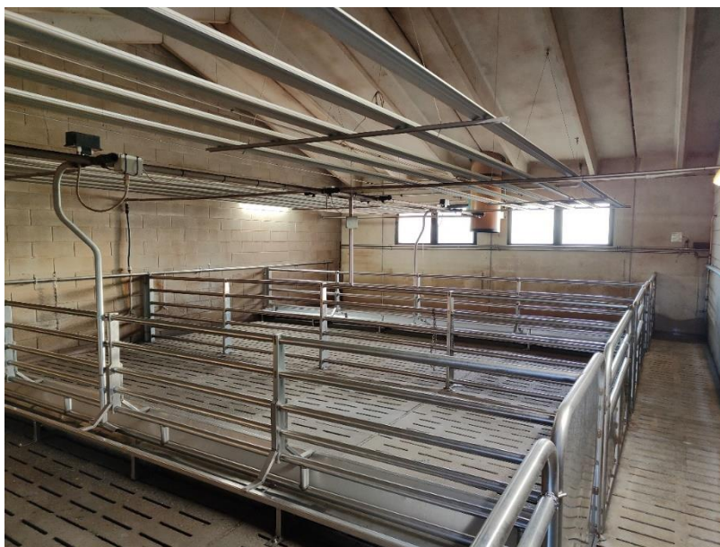
Foto 10. Interno dei 10 settori di allevamento del capannone 4
