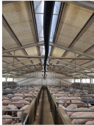
Foto 32. Tubo interno per la diffusione dell'olio essenziale
