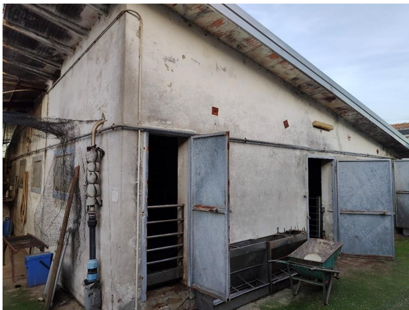
Foto 11: Esterno del capannone 5
