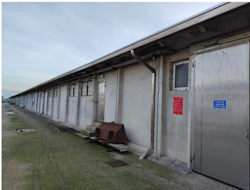
Foto 8. Esterno del capannone 4
