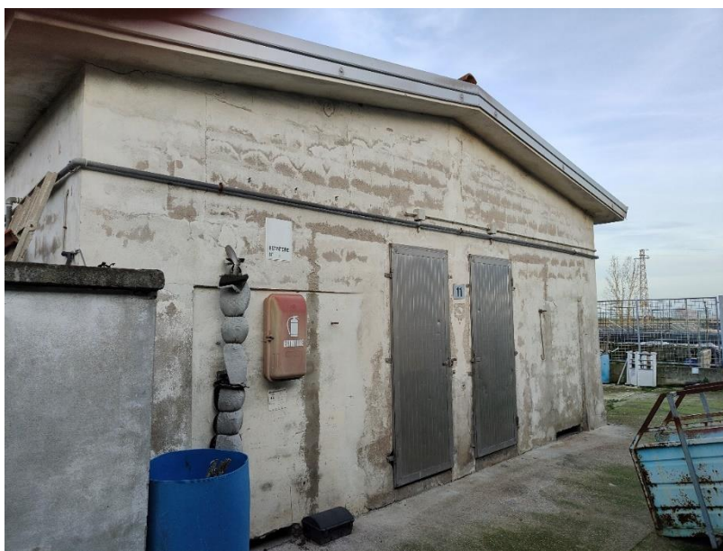
Foto 13: Esterno del capannone 6
