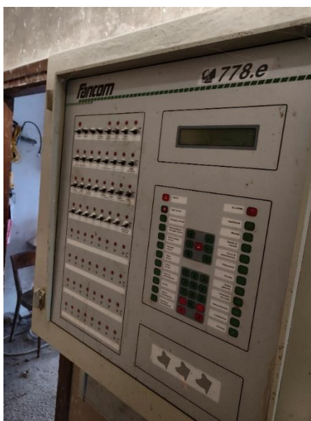
Foto 21. Computer di razioneamento dell'alimento
