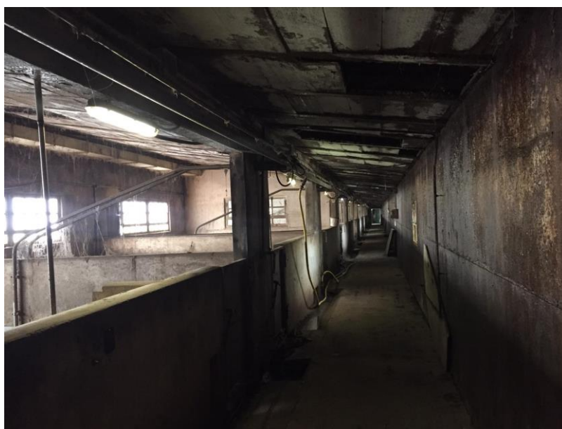
Foto 7. Vista del corridoio di movimentazione del vecchio capannone lato Nord
