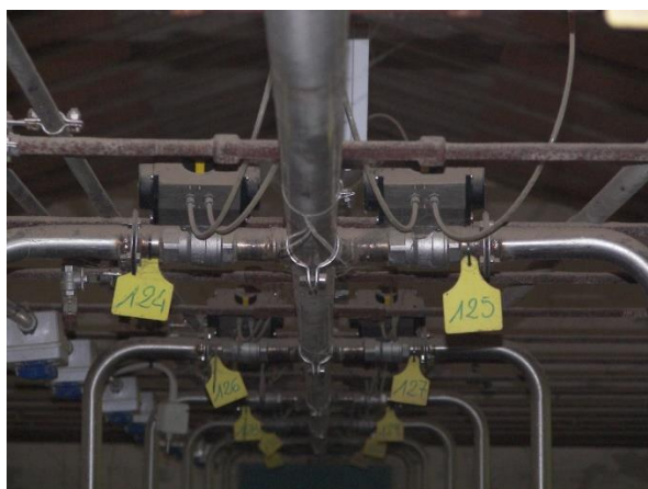
Foto 22. Elettrovalvole numerate di distribuzione della broda per ogni singolo box
