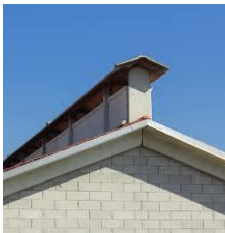
Fig.15 Particolare del cupolino di aereazione
