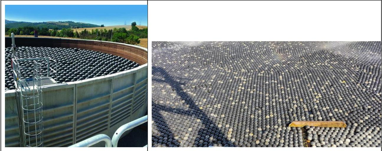
Figura 7. Vasche di stoccaggio liquami o di depurazione coperte con sfere per limitare le emissioni.
