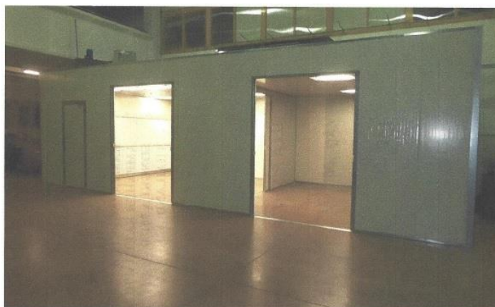
Figura 1 – Vista della nuova cabina di essiccazione e verniciatura
