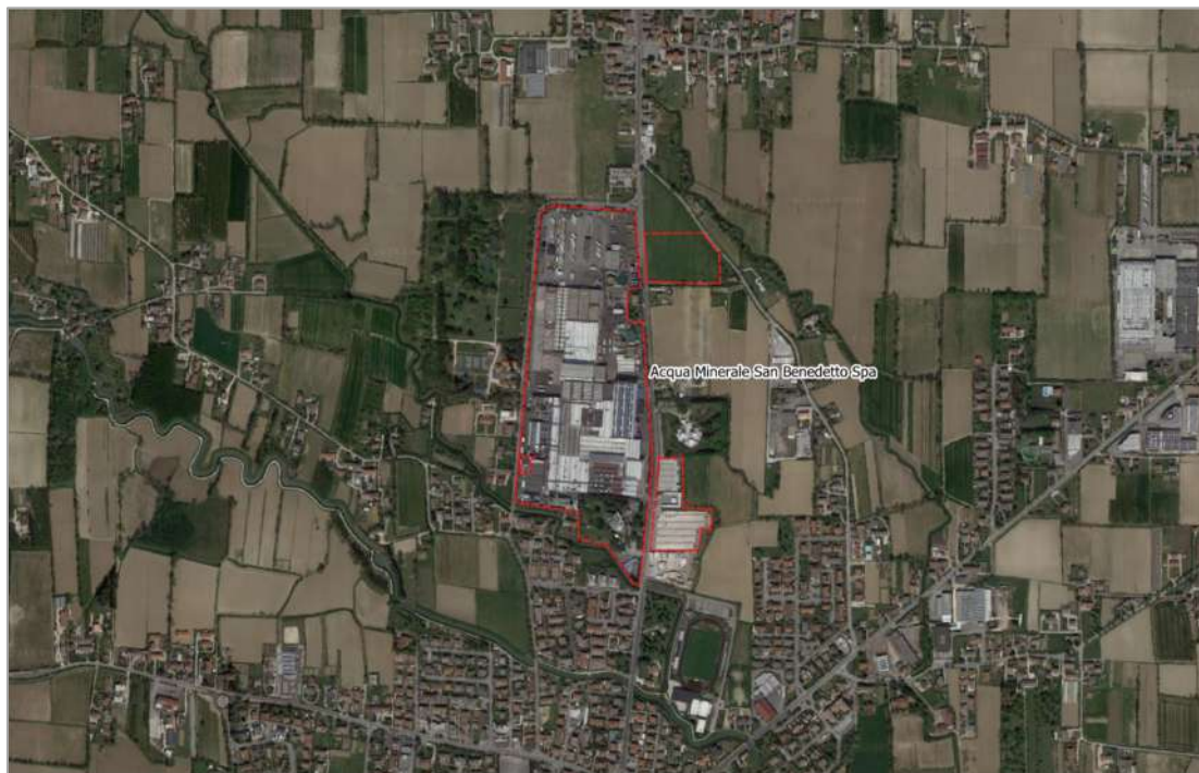
Figura 1.2 Fotografia aerea dell'area dello stabilimento (fonte: Google Earth Pro)
