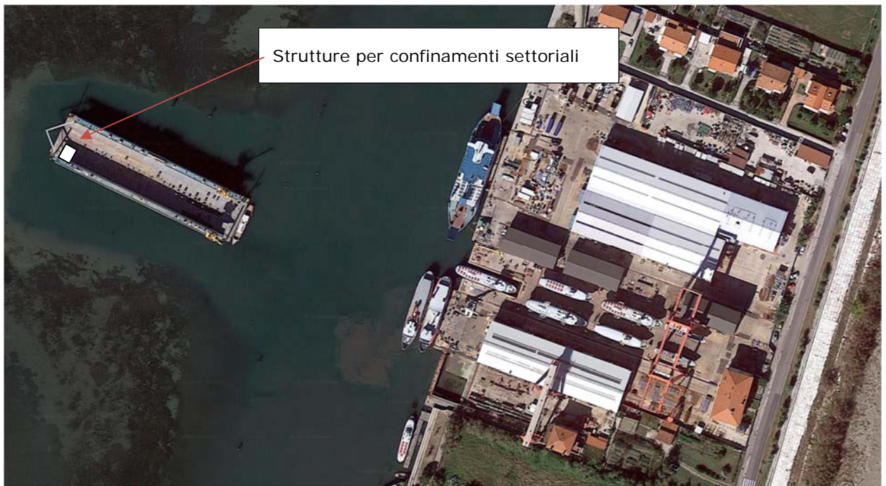
Figura 3 – Posizionamento strutture per confinamenti settoriali, la posizione varia ogni 24 ore circa e segue il perimetro dell'imbarcazione
