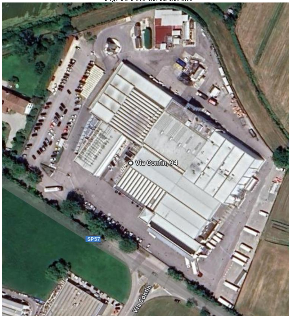
Fig. 18 Foto aerea del sito
