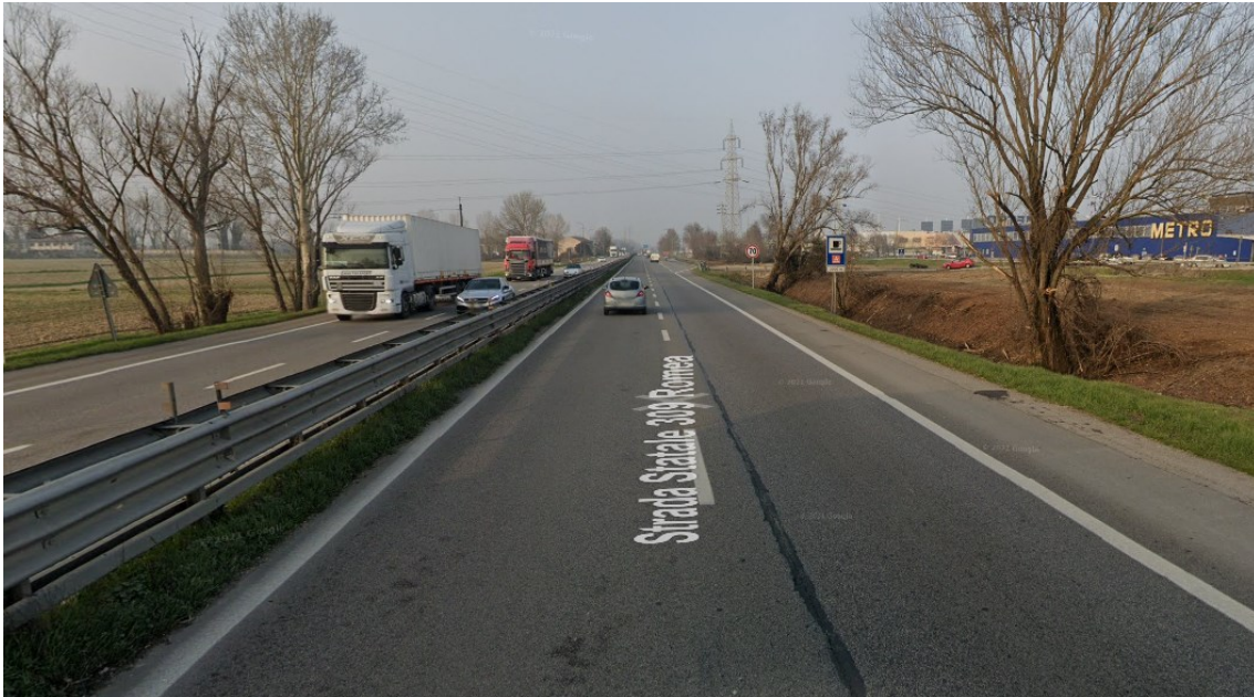
Fig. 9 – SS309 tratto compreso tra la rotonda di Marghera e la rotonda presso il Canale Industriale Ovest – direzione Nord
