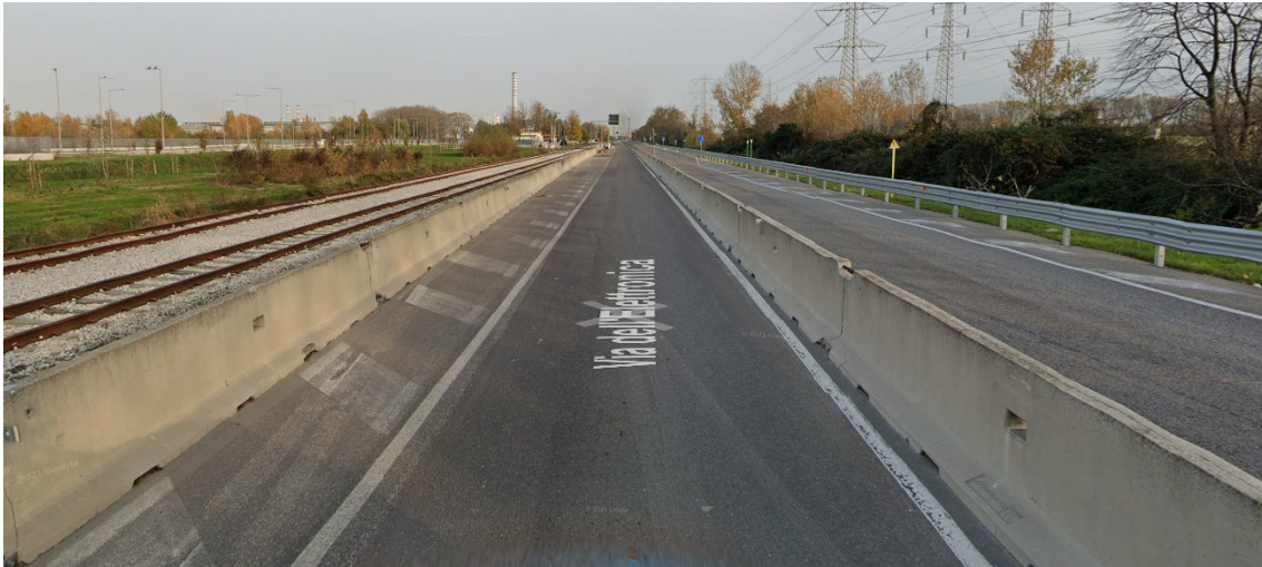
Fig. 4 – Tratto di Via dell'elettronica compreso tra Via della Geologia e Via della Meccanica
