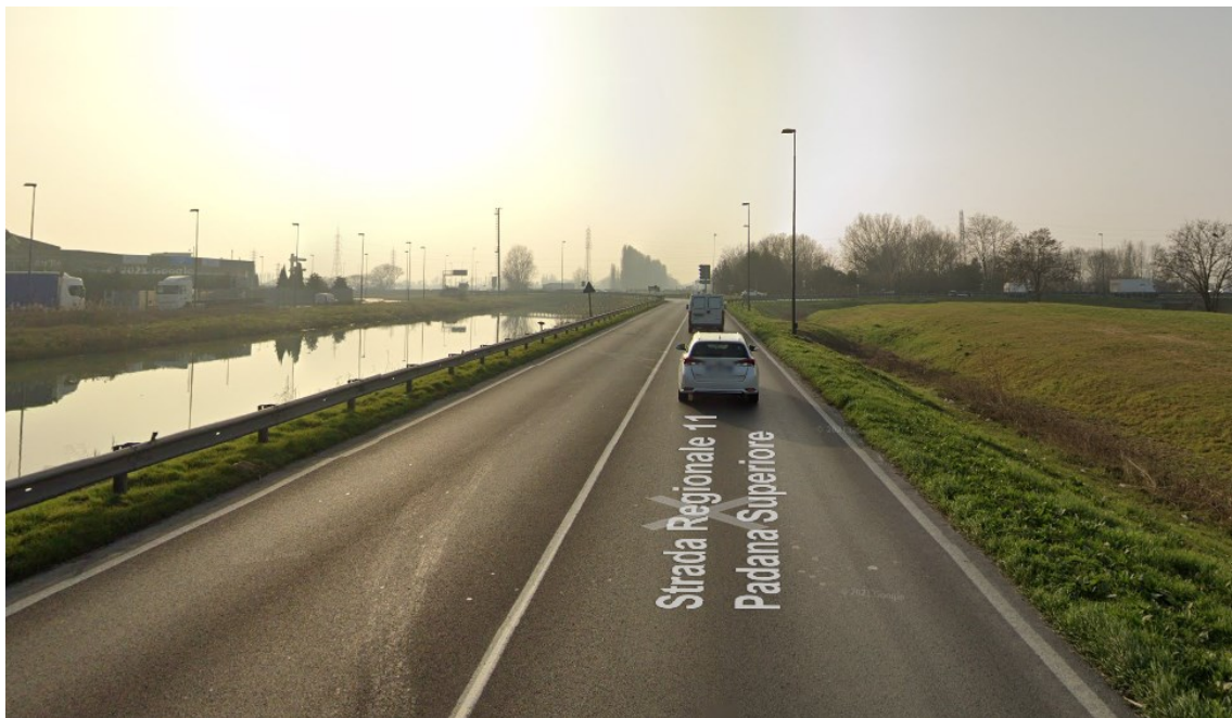
Fig. 13 – SR11 direzione Ovest verso rotatoria Canale Industriale Ovest
