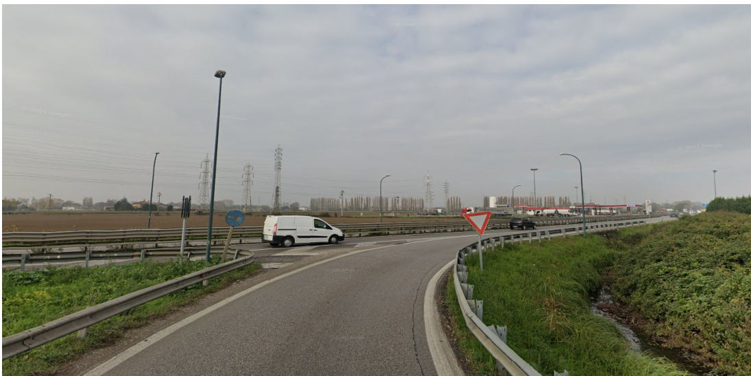
Fig. 7 - immissione sulla SS309 da Via delle Valli in direzione Nord
