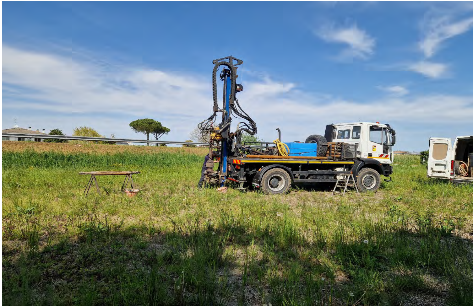
UBICAZIONE SONDA IN VIA CAVETTA MARINA NEL COMUNE DI JESOLO (VE)
